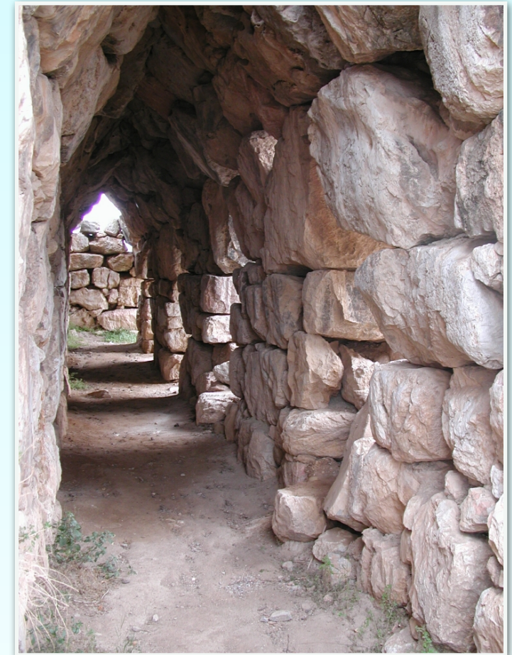
Mura ciclopiche di Tirinto (spessore 11 mt circa), veduta di un cunicolo di accesso.
